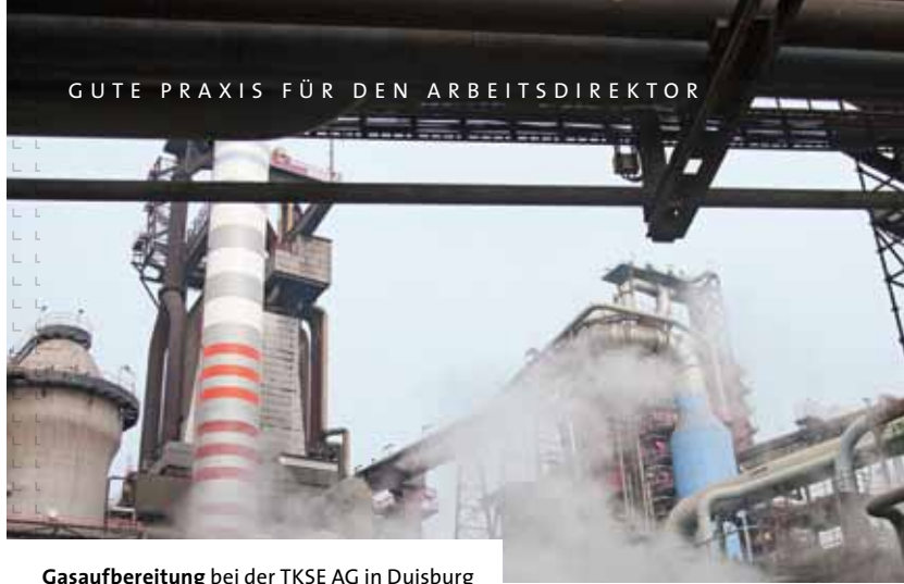
Gasaufbereitung bei der TKSE AG in Duisburg
